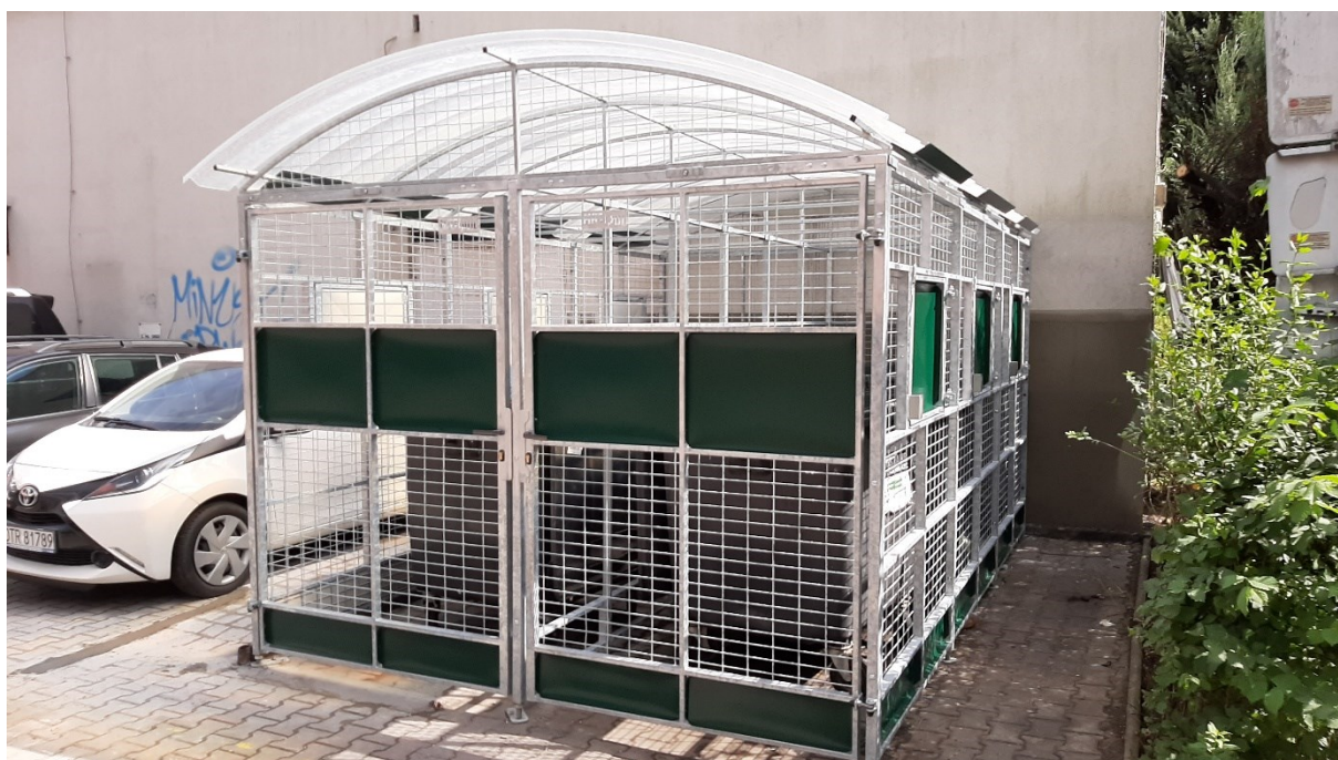
eko 6 wrzutowy brama na ścianie szczytowej SM Piekary Legnica
